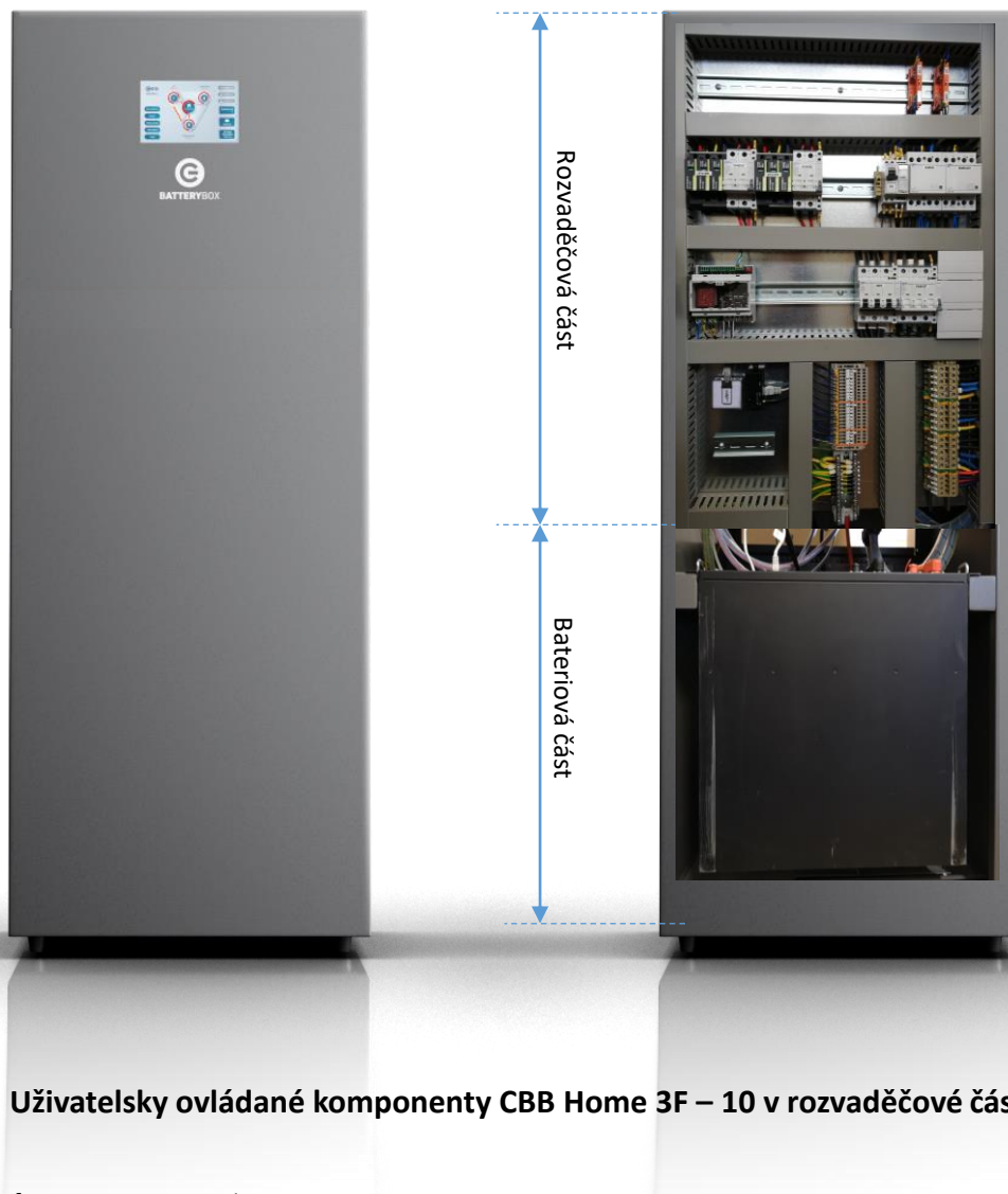
Obr. 1 – Fotografie systému CES BATTERY BOX HOME
